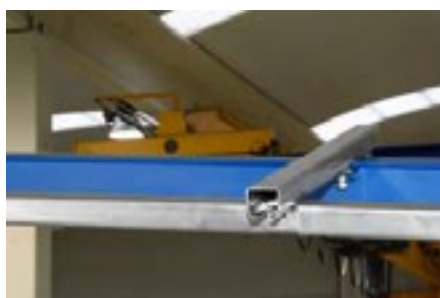
Instalar el primer perfil en los soportes sin apretar la tornillería de dichos soportes 2300/R-4.
