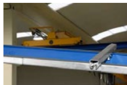
Montar el siguiente tramo de perfil en sus soportes 2300/R-4 correspondientes de la misma manera que el primero.
