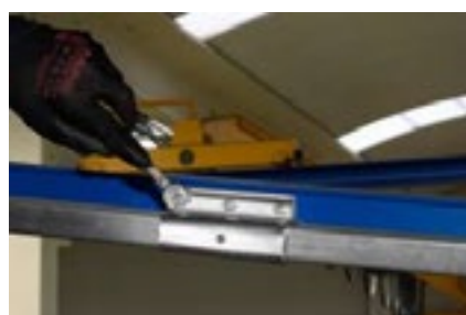
Unir dichos perfiles mediante el uso de los empalmes 2300/R-3-J que garantizan un recorrido continuo entre ambos tramos. Apretar los tornillos una vez que el empalme se haya situado en medio de ambos tramos de perfil.
