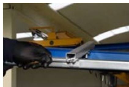
Una vez que todos los tramos han sido ya montados, procederemos a alinear el recorrido respecto a la viga de rodadura del polipasto, puente grúa, etc. a alimentar para garantizar que ambos recorridos son paralelos entre sí. Una vez que se han alineado correctamente, procederemos a apretar la tornillería de los soportes 2300/R-4.
