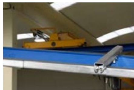
Montar el siguiente tramo de perfil en sus soportes 2500-4 correspondientes de la misma manera que el primero.
