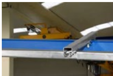
Instalar el primer perfil en los soportes sin apretar la tornillería de dichos soportes 2500-4.
